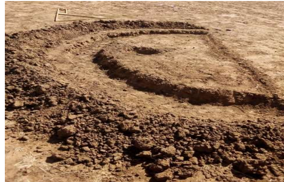
Réalisation d'une demi-lune après traçage à Akoubounou (A.K. SABRA)
