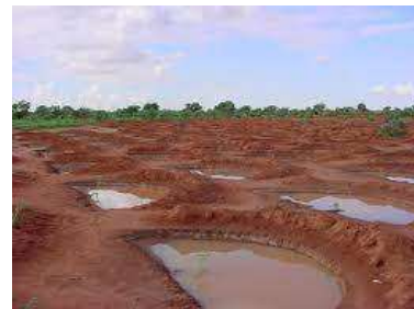
Comportement des ouvrages de Demi-lunes agricoles après pluie
