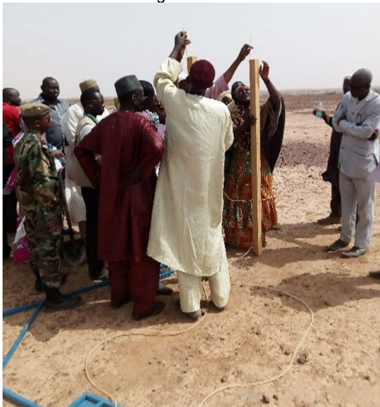
Utilisation du niveau à eau sur un site de récupération des terres dégradées
