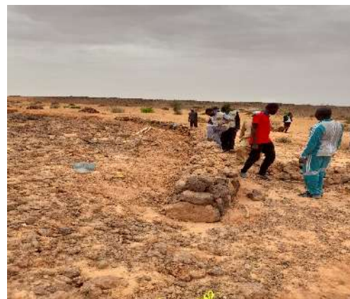
Réalisation de muret en pierres dans la région de Tahoua
