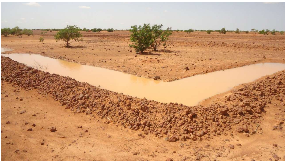
Image d'une banquette forestière remplie d'eau sur le site de Barakan (Ouallam) (photo Labo Yahaya)
