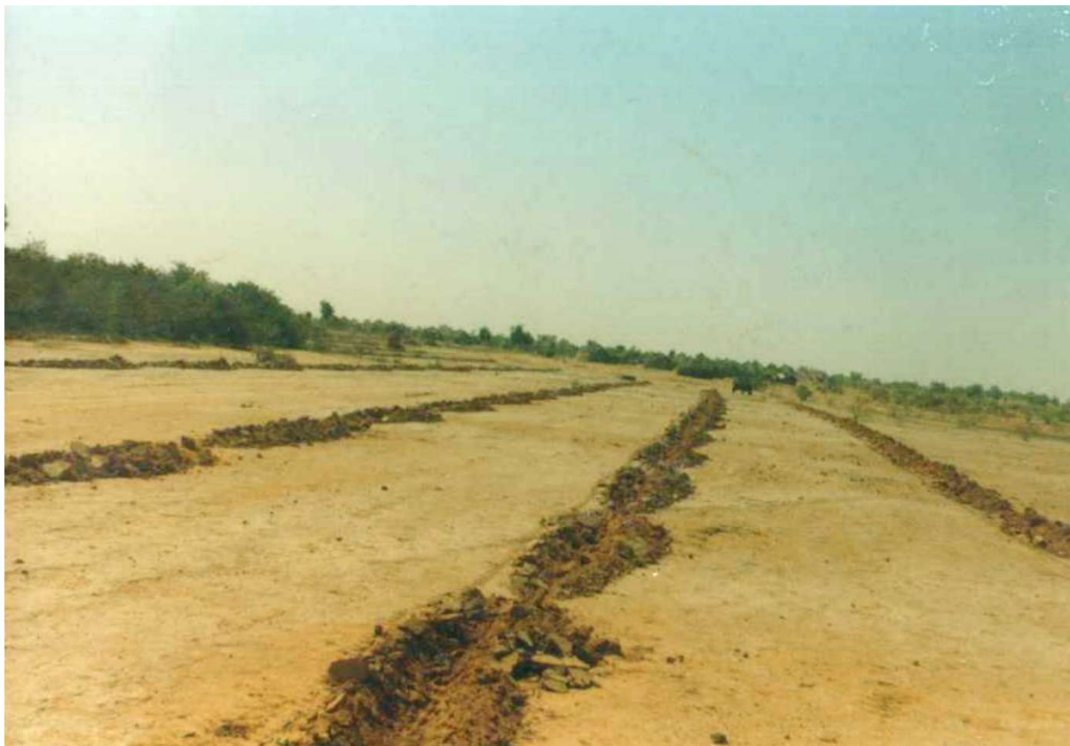
Tranchées Valarani Nardi nouvellement réalisée à Simiri (Ouallam) (Photo : PASP/GTZ).
