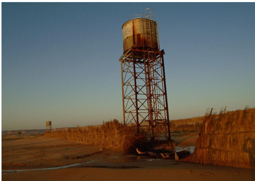
Figure 18: Château d'eau sur le site de Kalala (Bilma)
