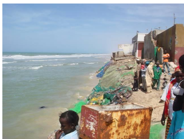
Photo 10 : Cordon longitudinal de protection de haut de plage constitué par des blocs de pierre retenus par un filet de pêche
