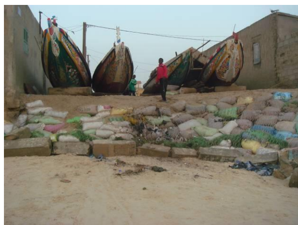
Photo 9 : Cordon longitudinal de protection de haut de plage constitué par des sacs remplis de sable
