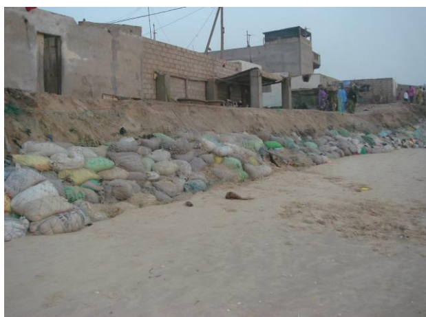
Photo 9 : Cordon longitudinal de protection de haut de plage constitué par des sacs remplis de sable
