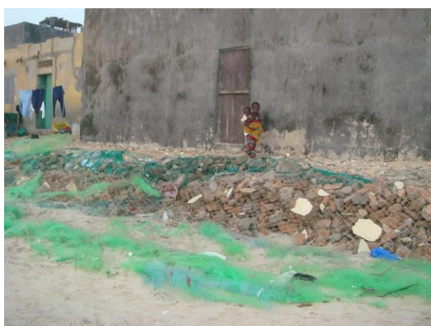
Photo 10 : Cordon longitudinal de protection de haut de plage constitué par des blocs de pierre retenus par un filet de pêche
