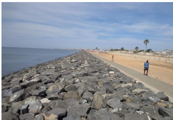
Photo 5 : La digue de Thiawllène vue du sol (Source : B. Dramé, 2013)
