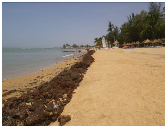
Photo 8 : gabion érigé à Saly
